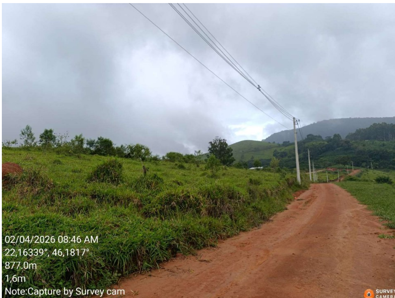
Imagem 02 – Rede de Energia Elétrica
